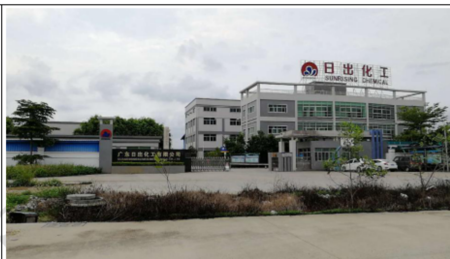
项目北面 日出化工厂
