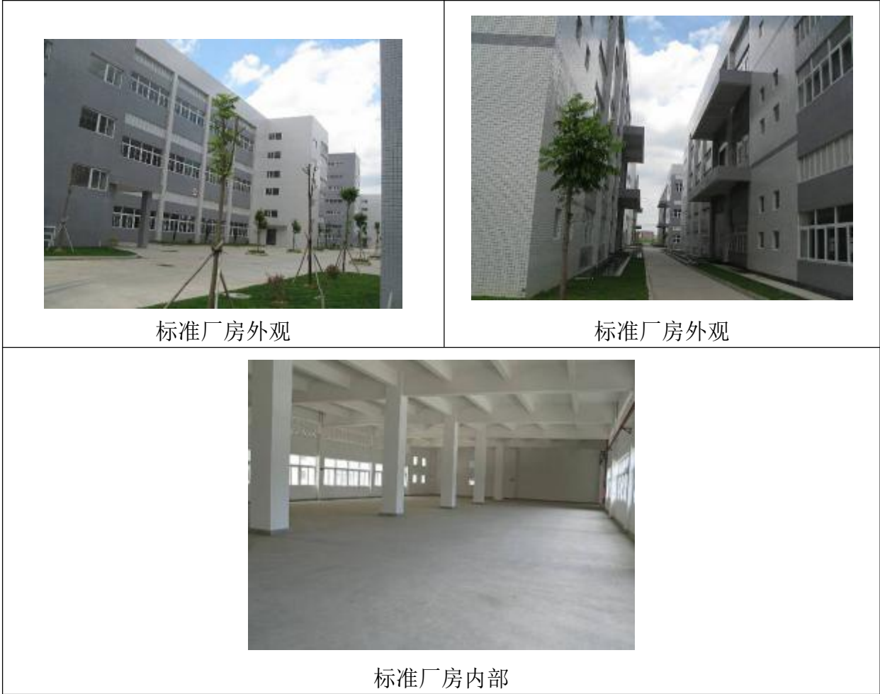
图 2.2-3 基地二期已建设的标准厂房现状
