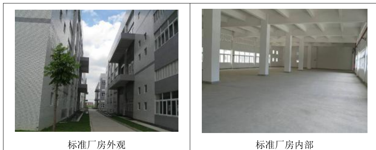
图 2.2-1 基地一期已建设的标准厂房现状
